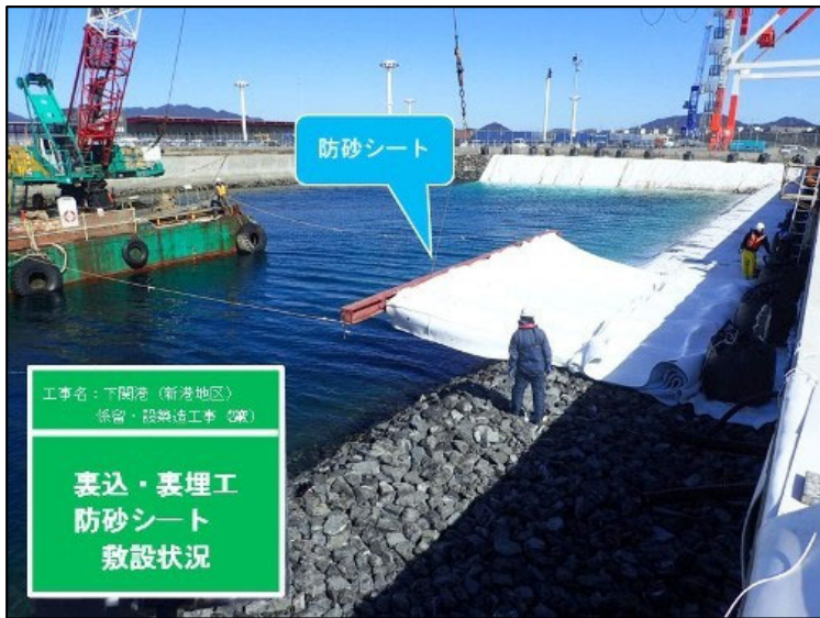
防砂シートの敷設作業(イメージ)
